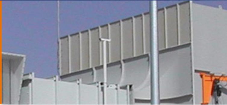
Das Schallschutzelement mit schallabsorbierender gelochter Innenschale eignet sich vorwiegend für den Einsatz in Innenräumen. In dem von Metecno patentierten System ist zwischen der Innenschale und dem Dämmkern aus Mineralwolle ein spezielles Vlies als Rieselschutz eingelegt. Die Ausbildung der Innenschale trägt erheblich zur Verbesserung der Raumakustik bei. Außerdem werden durch die hohe Dichte des Dämmkerns gute Schalldämmwerte erreicht. Nach Rücksprache mit uns und nach Über-
